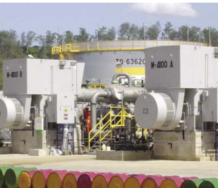
Motores Síncronicos SEF900 (Ex-p), 3.600 kW, 13.200 V Aplicación: Compresores recíprocos
